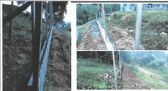
FOTO 1: SE ESTÁ FUNDIENDO EL CIMIENTO CORRIDO, COLOCANDO LAS HILADAS DE BLOCK Y ESTÁN COLOCANDO LOS TUBOS PARA LA CIRCULACIÓN CON MALLA EN LA ESCUELA.
