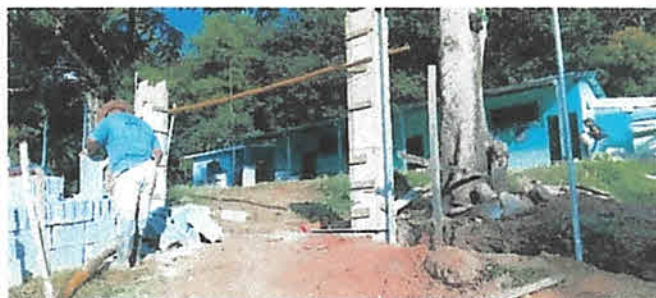
FOTO 2: SE INICIA LA FUNDICIÓN DE COLUMNAS PARA EL SOSTENIMIENTO DEL PORTÓN DE DOS HOJAS CON TUBO GALVANIZADO Y MALLA PARA CERCA.
