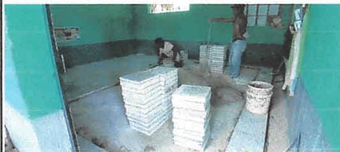
FOTO 3: COLOCACIÓN DE PISO DE GRANITO EN AULAS Y CORREDOR DE LA ESCUELA.
