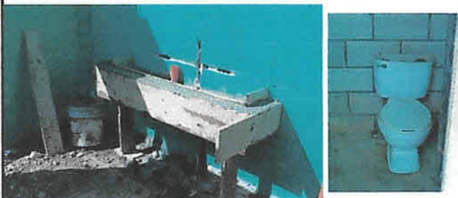
FOTO 5: CONSTRUCCIÓN DE LAVAMANOS DE CONCRETO FUNDIDO Y REPARACIÓN DE LAS TRES TAZAS SANITARIAS.
