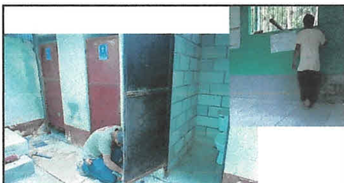
FOTO 4: DESMONTAJE DE PUERTAS DE SANITARIOS PARA DARLES MANTENIMIENTO Y COLOCACIÓN DE VENTANAS DE PVC EN LAS AULAS.
